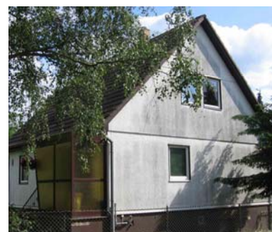
Abb. 3. 4. und 5. Elementfugen / Wärmebrücken / Veralgte Putzfassade
