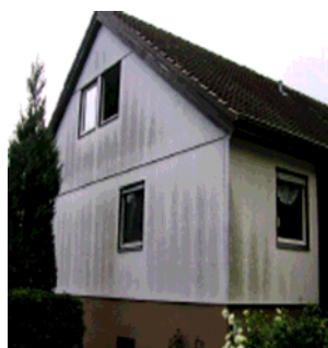
Abb. 3. 4. und 5. Elementfugen / Wärmebrücken / Veralgte Putzfassade
